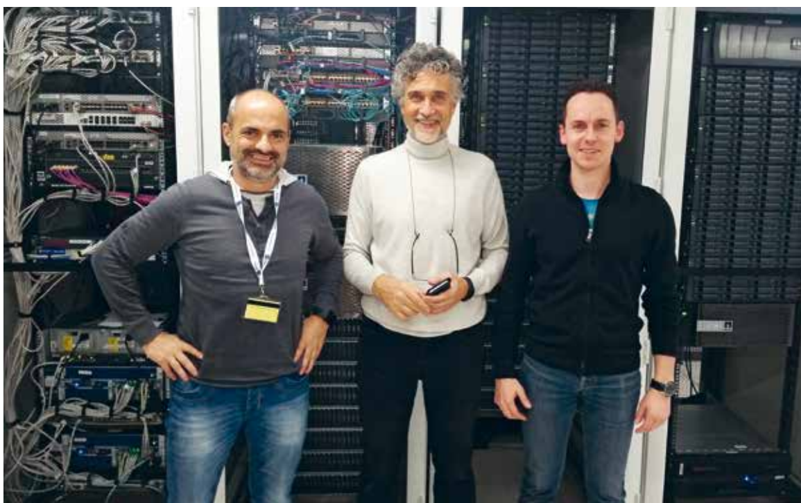
Das Service- & System-Management-Team nach erfolgter Migration der Infrastrukturen des Wiederherstellungszentrums in das DataCenter der ICCREA2 in ROM.
